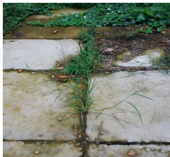
Hình 2.13. Hầm chôn xác gia súc chết tại cơ sở chăn nuôi tập trung
