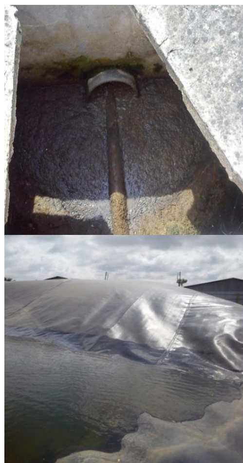
Hình 2.10. Chất thải được xử lý bằng hầm biogas
