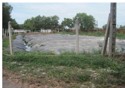
Hình 5.1: Công trình khí sinh học
