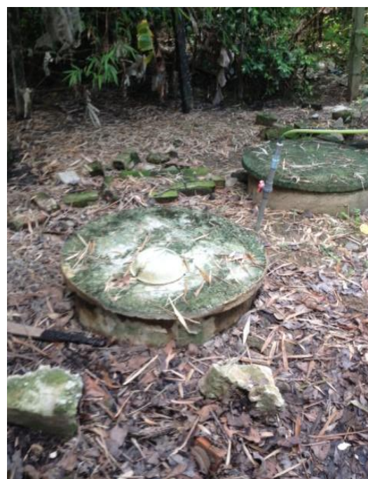
Hình 2.6. Hàm biogas xử lý nước thải và sử dụng khí gas phục vụ sinh hoạt gia đình
